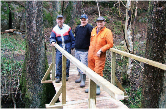
Grunneierne hadde for anledningen laget flott, ny bru over Kvennbekken. Fra venstre Olav Thormod Aakvåg, Oddvar Pedersen og Odd Åsmundhavn. Foto: Yngvar Øigarden 2012
