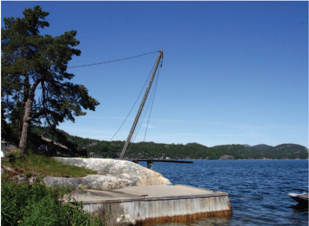
Mastebukken på Hammeråker. Den blei brukt av alle båtbyggeriene på Moen når de skulle heise mastene på plass. Foto: DP 2009.
